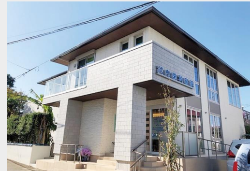
院内は最新医療用HEPAフィルター空調が稼働
